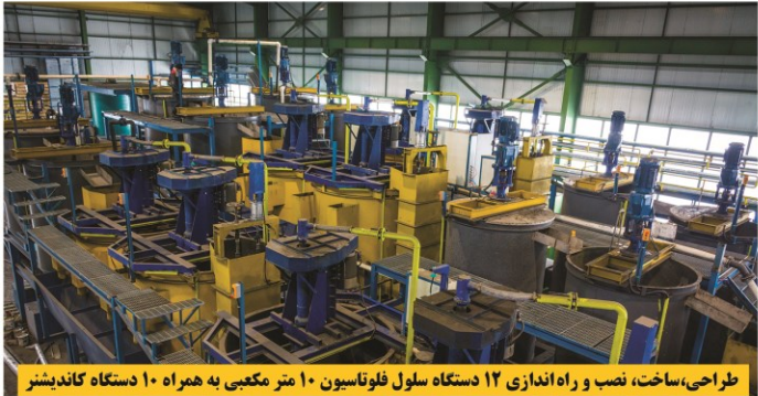
اجرای خط تولید کنسانتره روی از باطله کیک های انحلال
